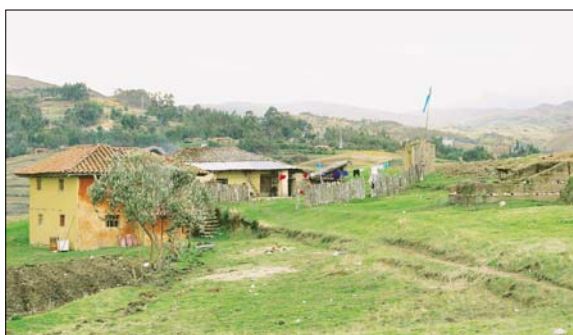
Inmitten von Eukalyptushainen gelegen: der Bauernhof der Familie Abanto-Requielme oberhalb der 7000 Einwohner zählenden Gemeinde Encañada.
